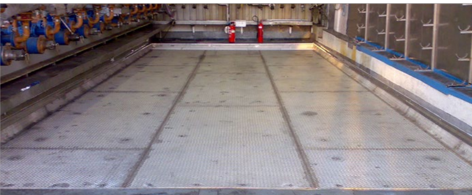
Bodenschutz-Auskleidung in Edelstahl
